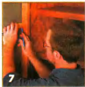
Двухпазовая конструкция облегчает подгонку. Чтобы приспособиться к немного прогнутым стенам, делают внешние стойки шире на 6 мм. Выпиливают первый паз для конечного положения и второй — для подгонки.
