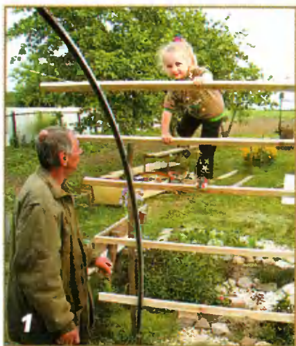
Внучка проверяет на прочность каркас будущего навеса, дедушка боится юного верхолаза.
