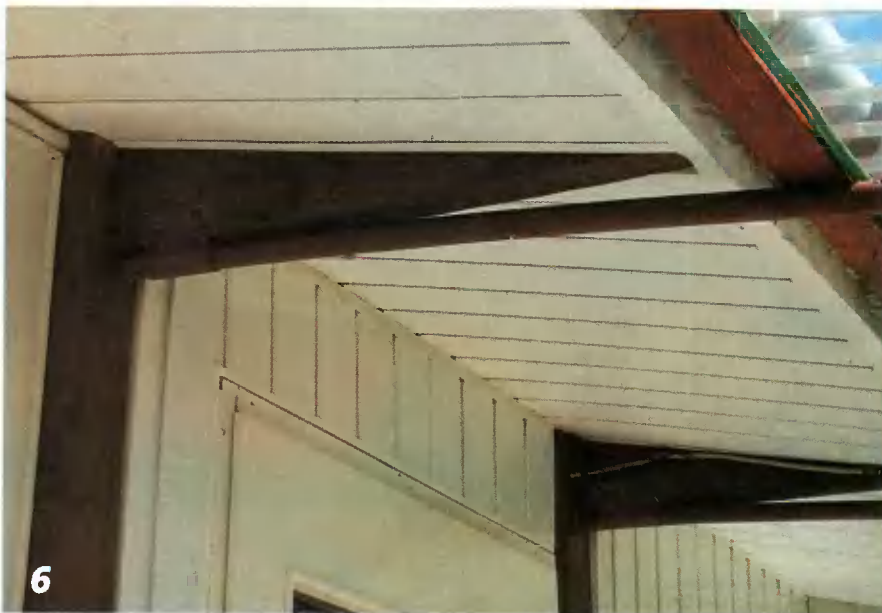
При помощи хомутов, сделанных из кровельного железа, дуги каркаса арочного навеса прикреплены к свесу крыши. Листы прозрачного поликарбоната одним концом подсунуты под сливной желоб на крыше дома, а другой конец листов прикреплен к деревянным рейкам каркаса навеса шурупами.
