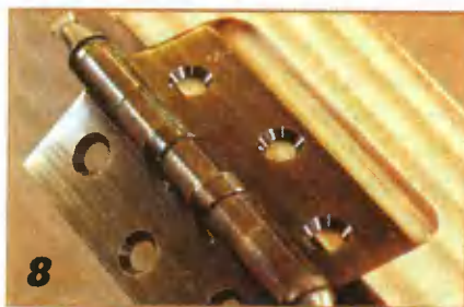
8 Вкладывают петлю в гнездо, проверяя правильность выборки глубины и ширины гнезда.
