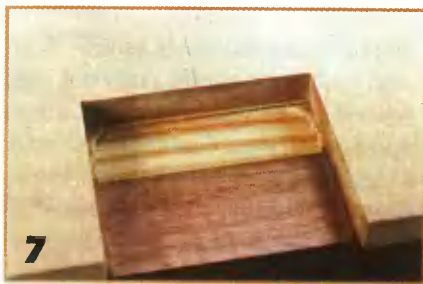
7 Делают проход вдоль кромок проема шаблона и удаляют ненужную древесину.
